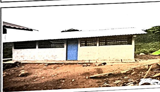
Foto 3: se observa enfrente el trabajo culminado
