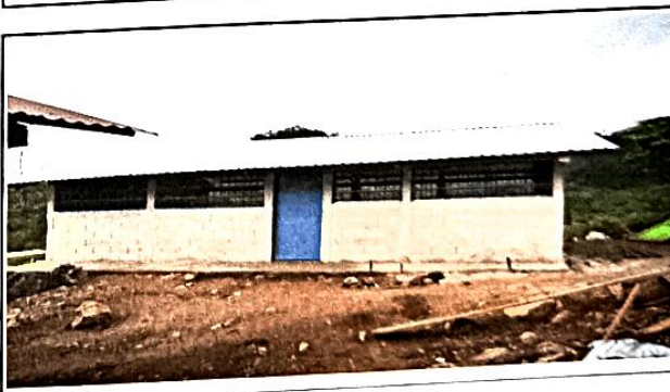
Foto 6: se observa la finalizaion de trabajo
